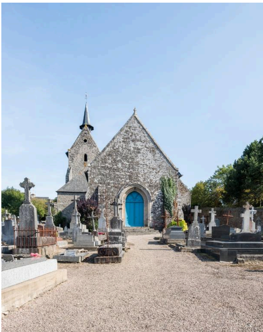
Façade occidentale, vue d'ensemble
