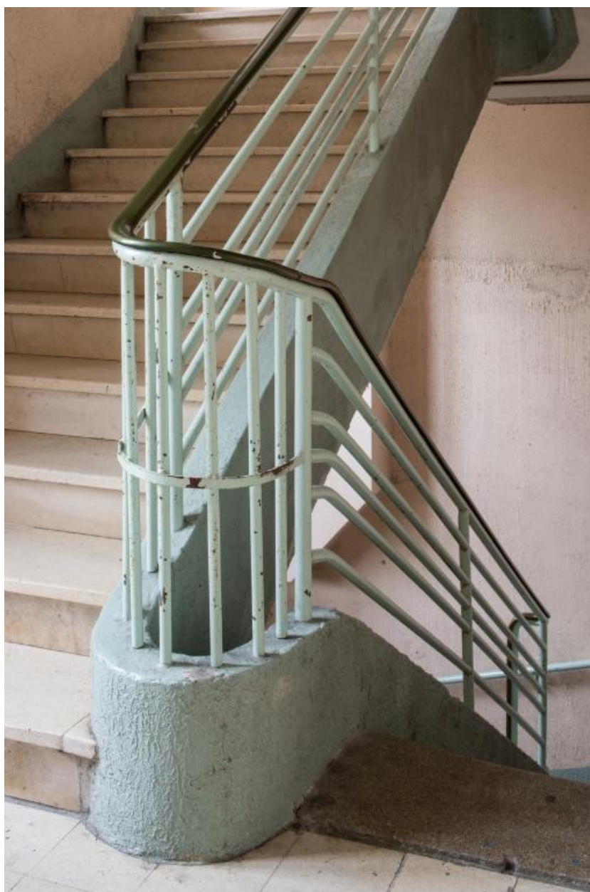
Cage d'escalier dans l'ancien séminaire réhabilité (vers 1950-1960).
