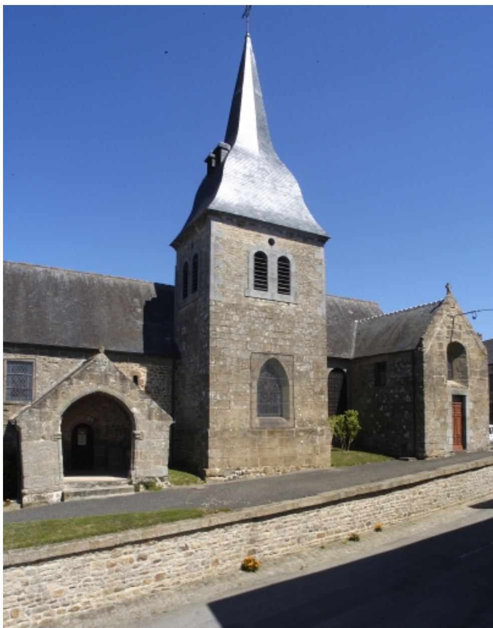
Elévation sud, porche et clocher
