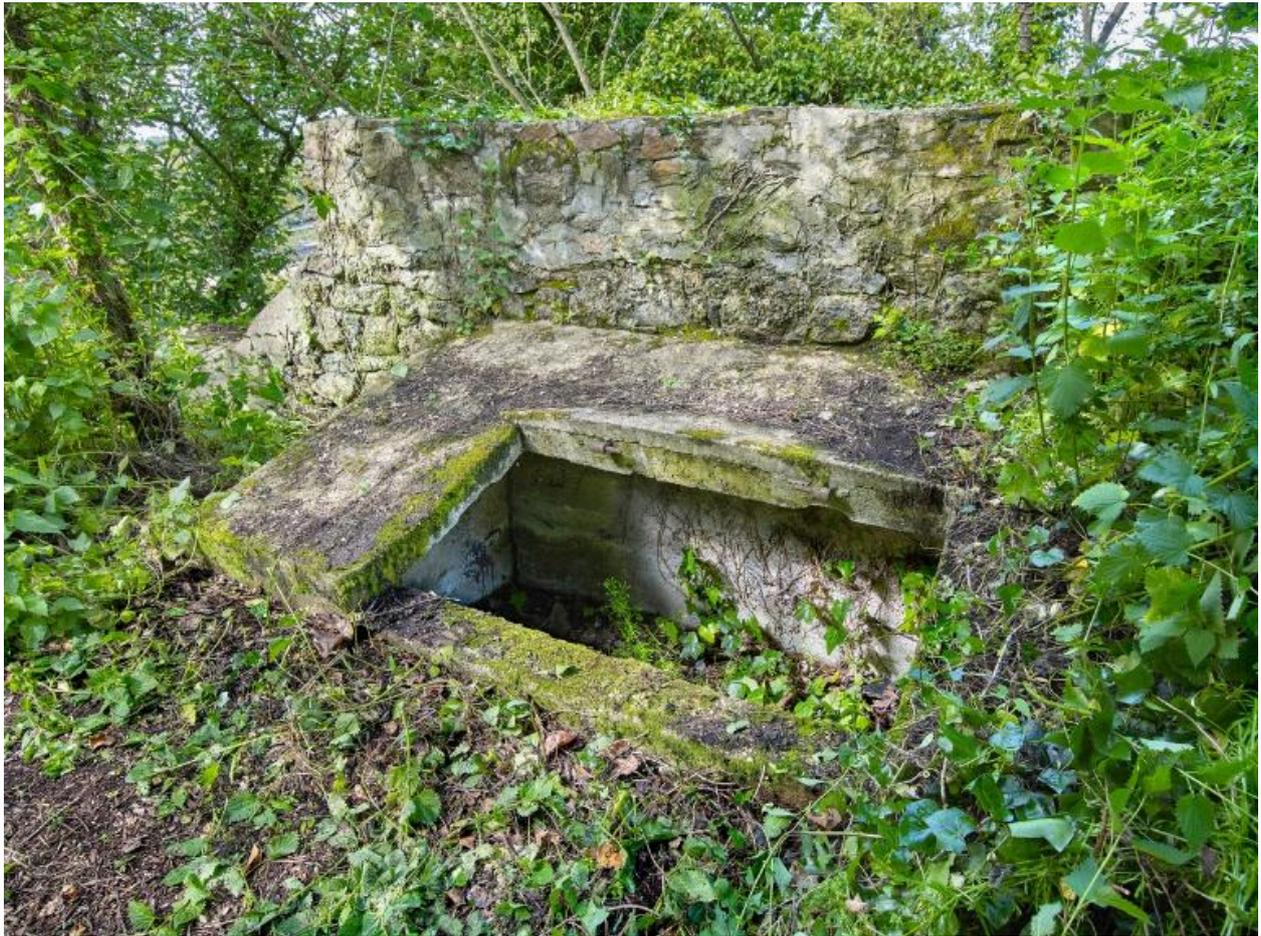
Vue générale. La niche à munitions est adossée au parapet du mur ceinturant le Domaine de Cesson. Elle était vraisemblablement fermée par un battant vertical dont subsistent les gonds
