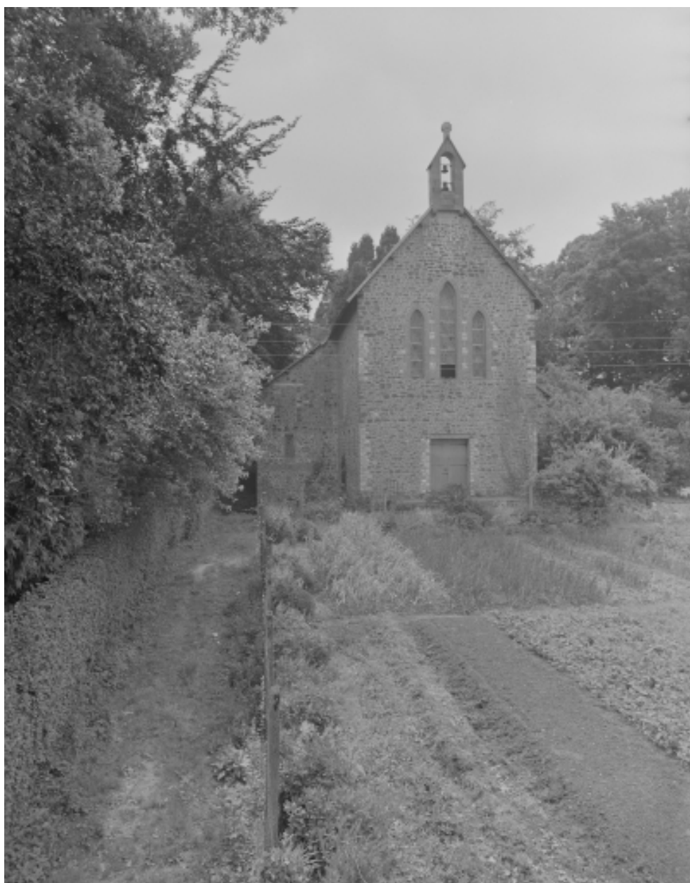
Elévation Ouest : vue générale
