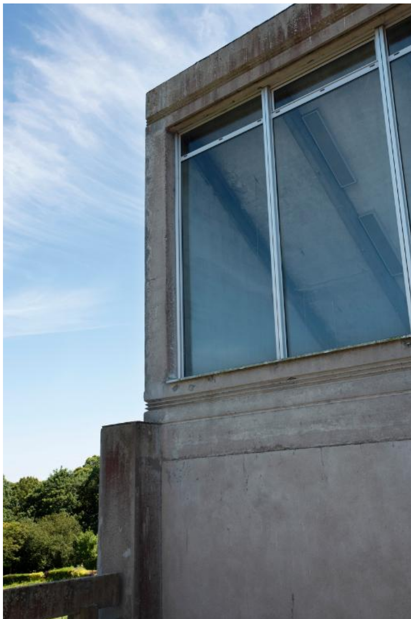
Baie donnant sur une terrasse : détail sur la modénature moulée dans le béton.
