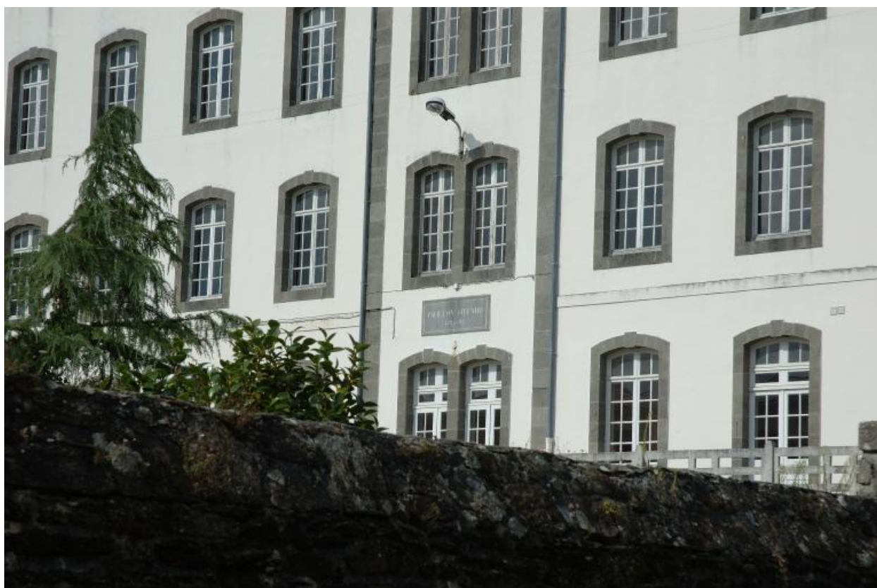
Vue générale : détail de l'élévation principale orientée vers le sud-sud-ouest (état en 2005)
