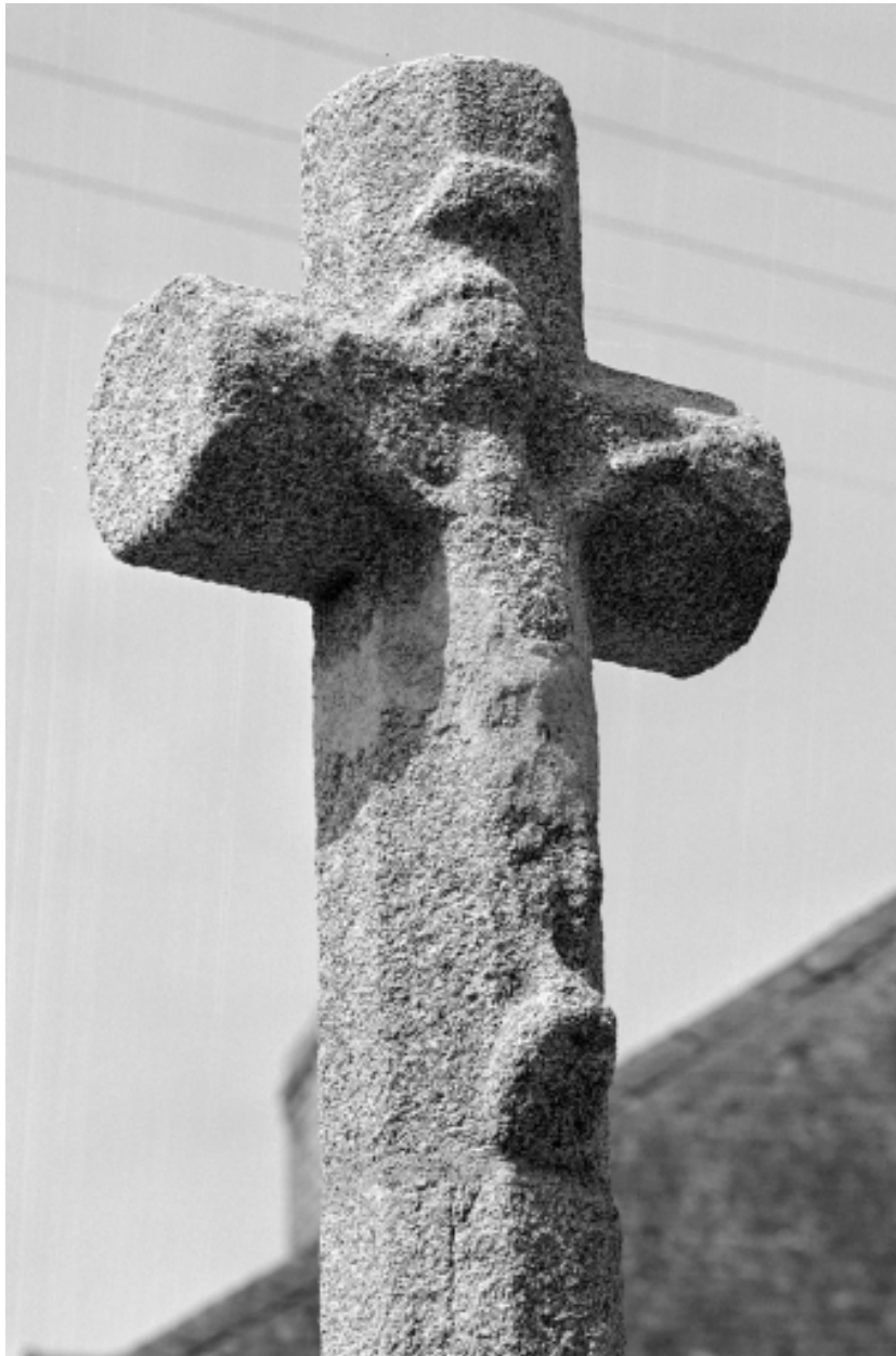
Croix du cimetière, détail du croisillon.
