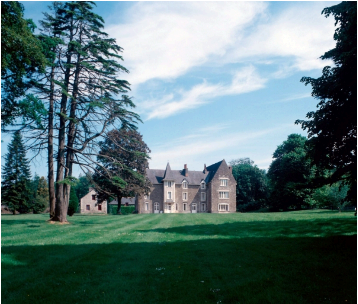
Vue générale sud
