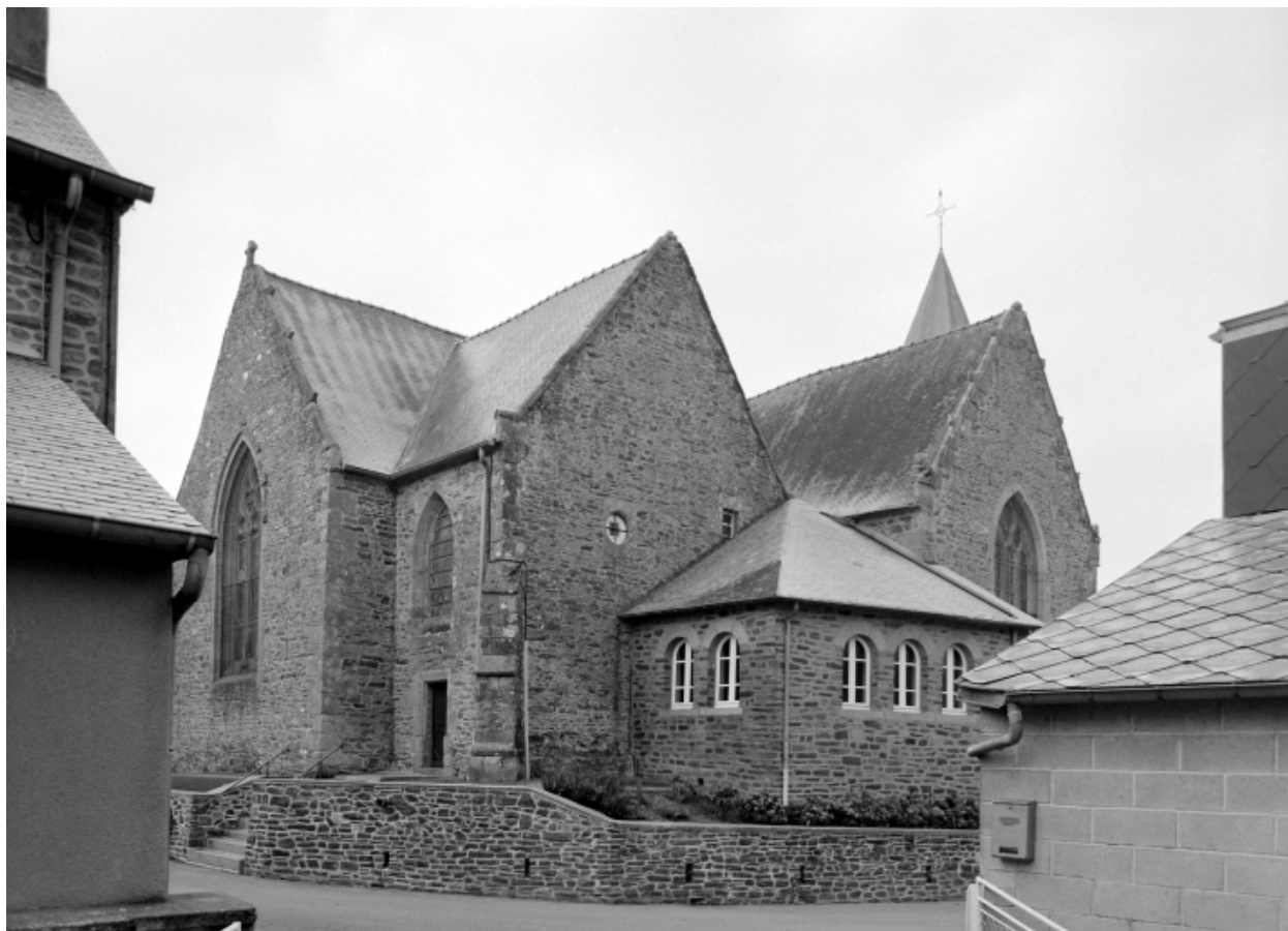
Elévation Nord-Est : vue générale
