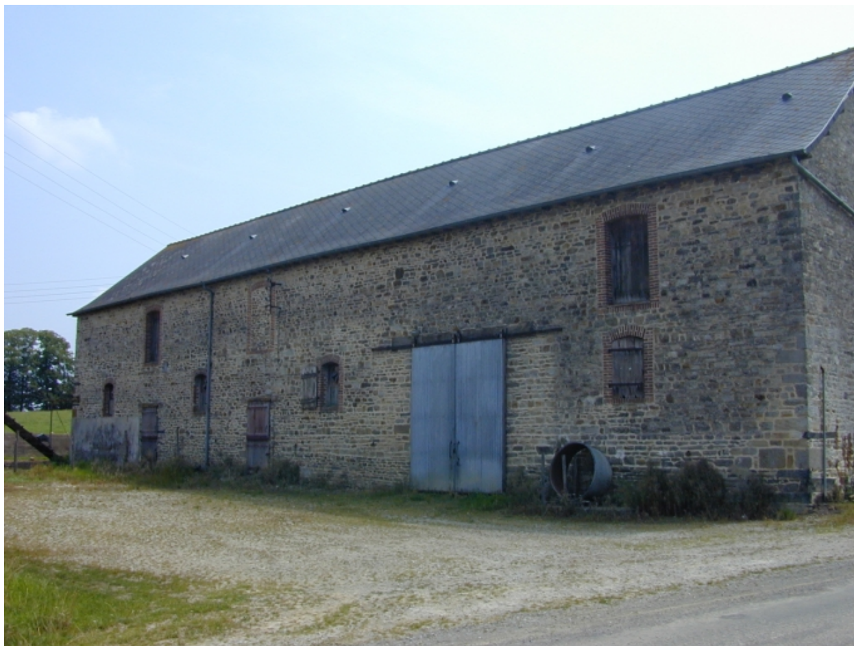
Les étables et la grange : vue générale sud-ouest
