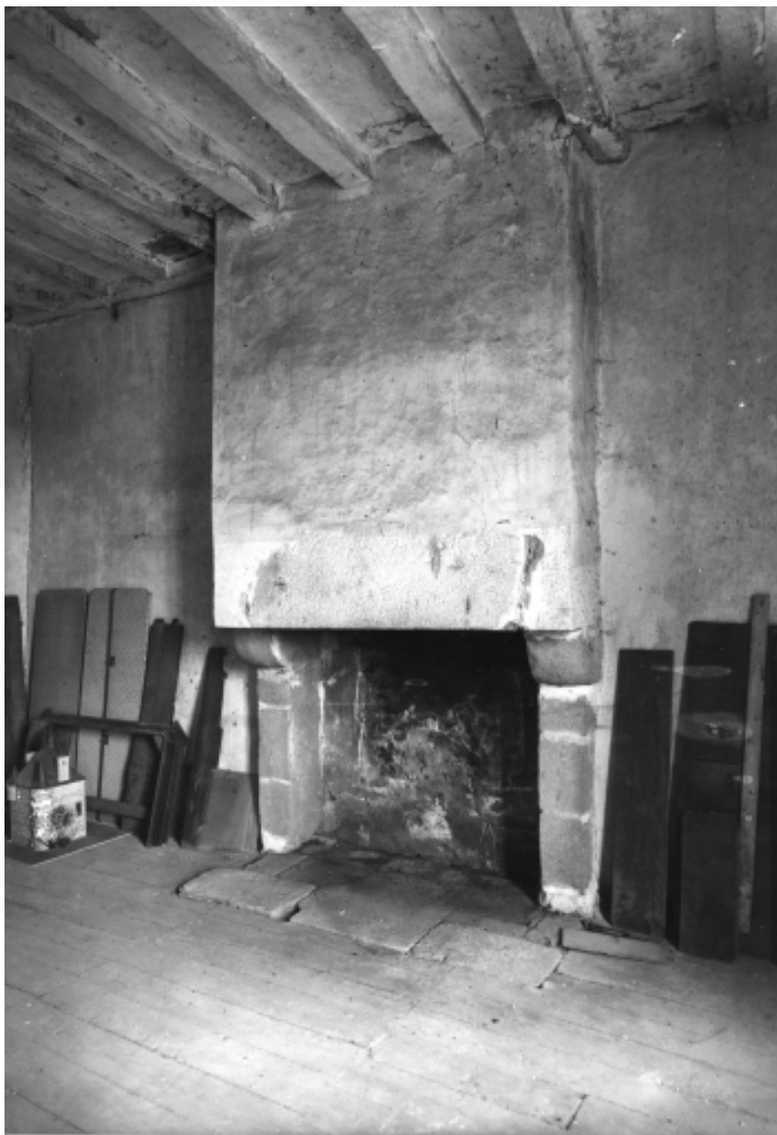
Corps de logis principal, étage, chambre est, cheminée sur mur est. Etat en 1978.
