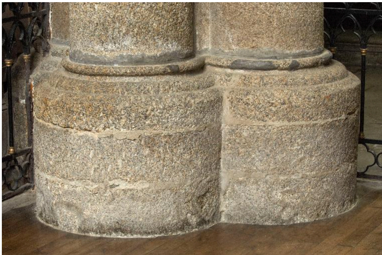
Bases des piles du choeur
