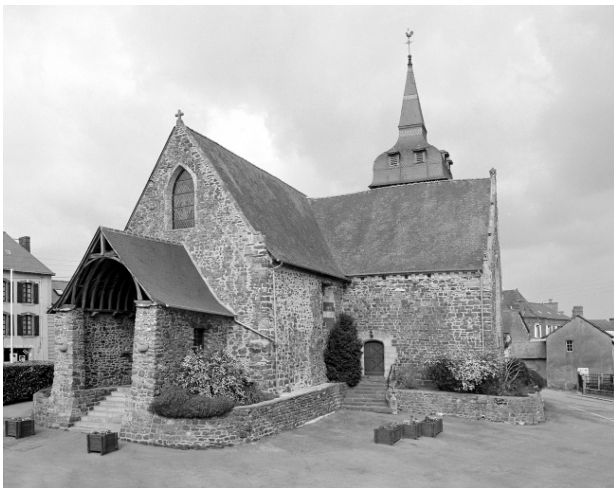
Élévation Sud-Ouest : vue générale
