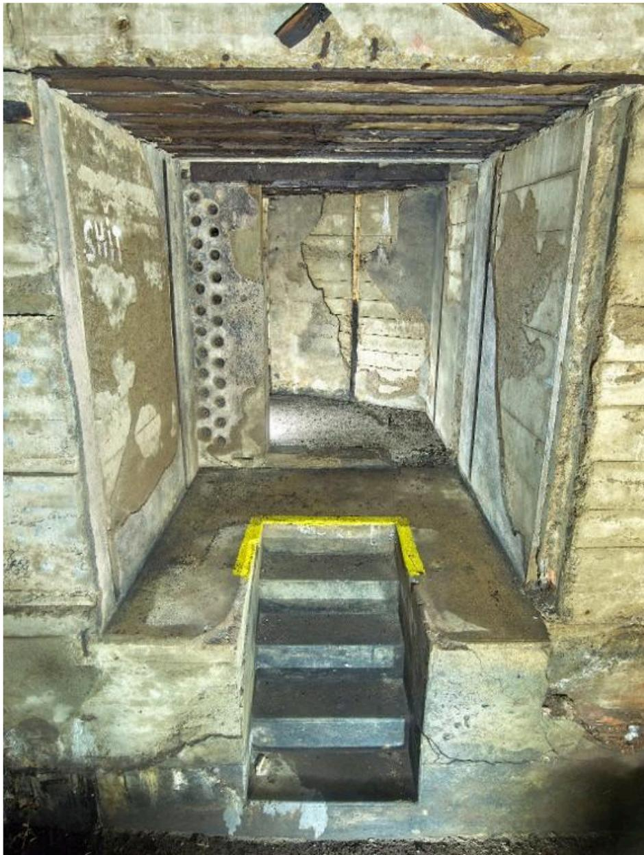
Vue du bunker - abri de type 485 long pour radar Mammout : passages de câble de la salle des compensateurs au puits d'antenne sud-ouest via un sas étanche. Au premier plan, gaine technique de la salle des compensateurs accessible par un escalier
