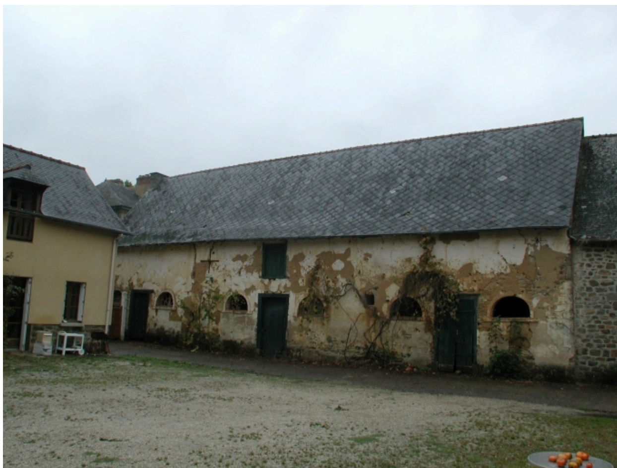
Ferme : vue générale de la cour vers le nord
