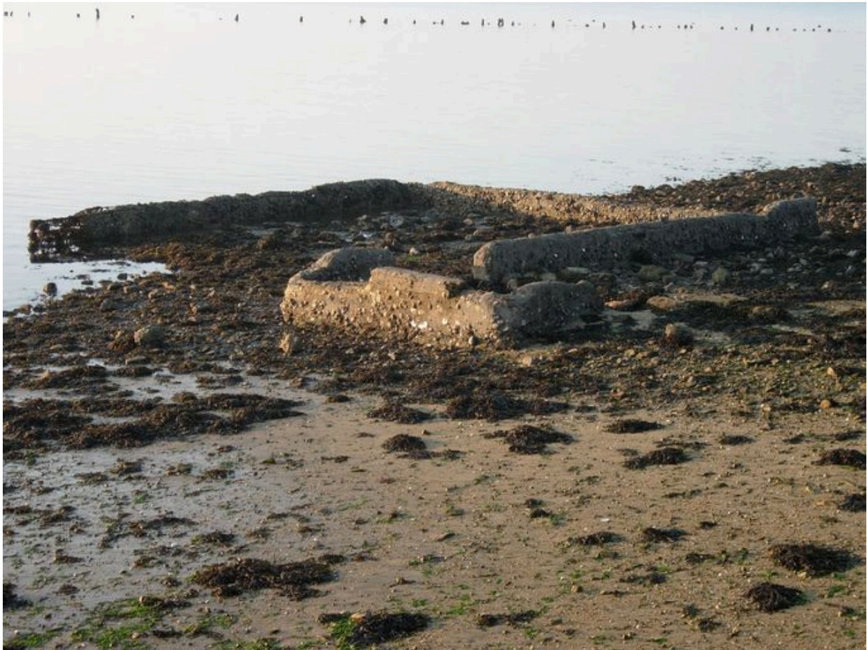
Vue générale du bassin de décantation à huîtres
