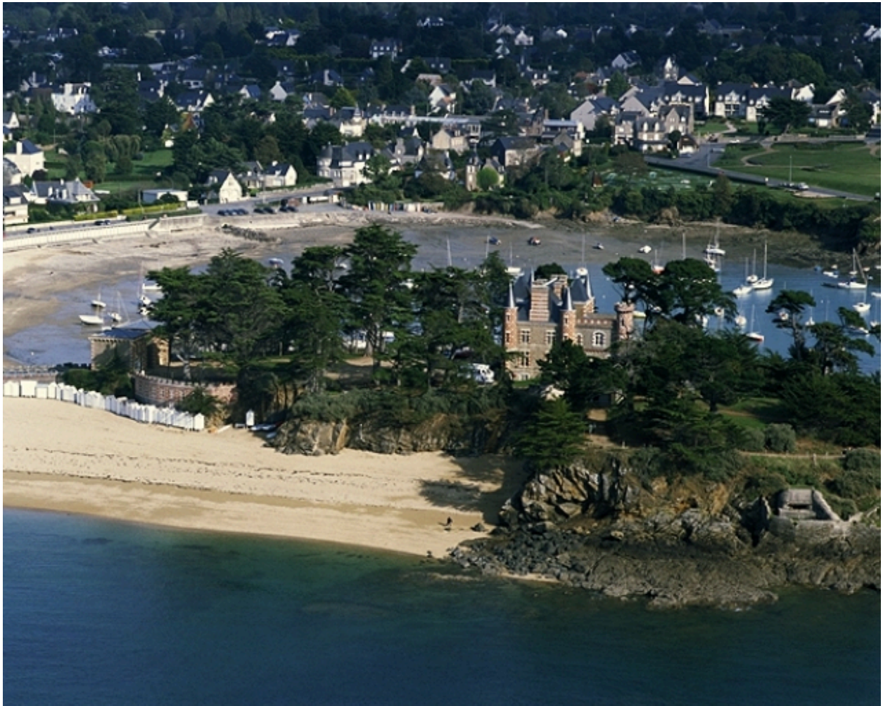
Vue aérienne depuis l'ouest
