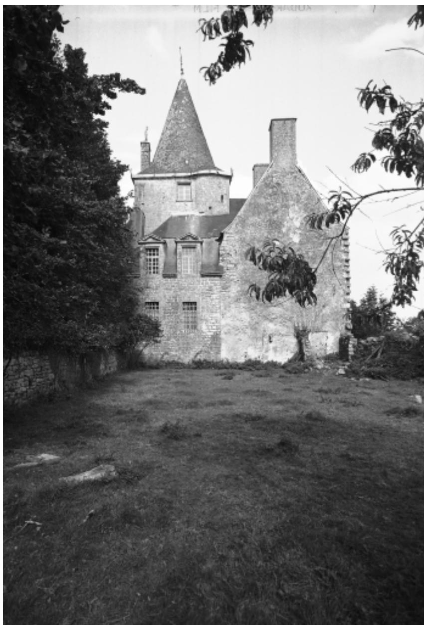
Façade ouest : vue générale
