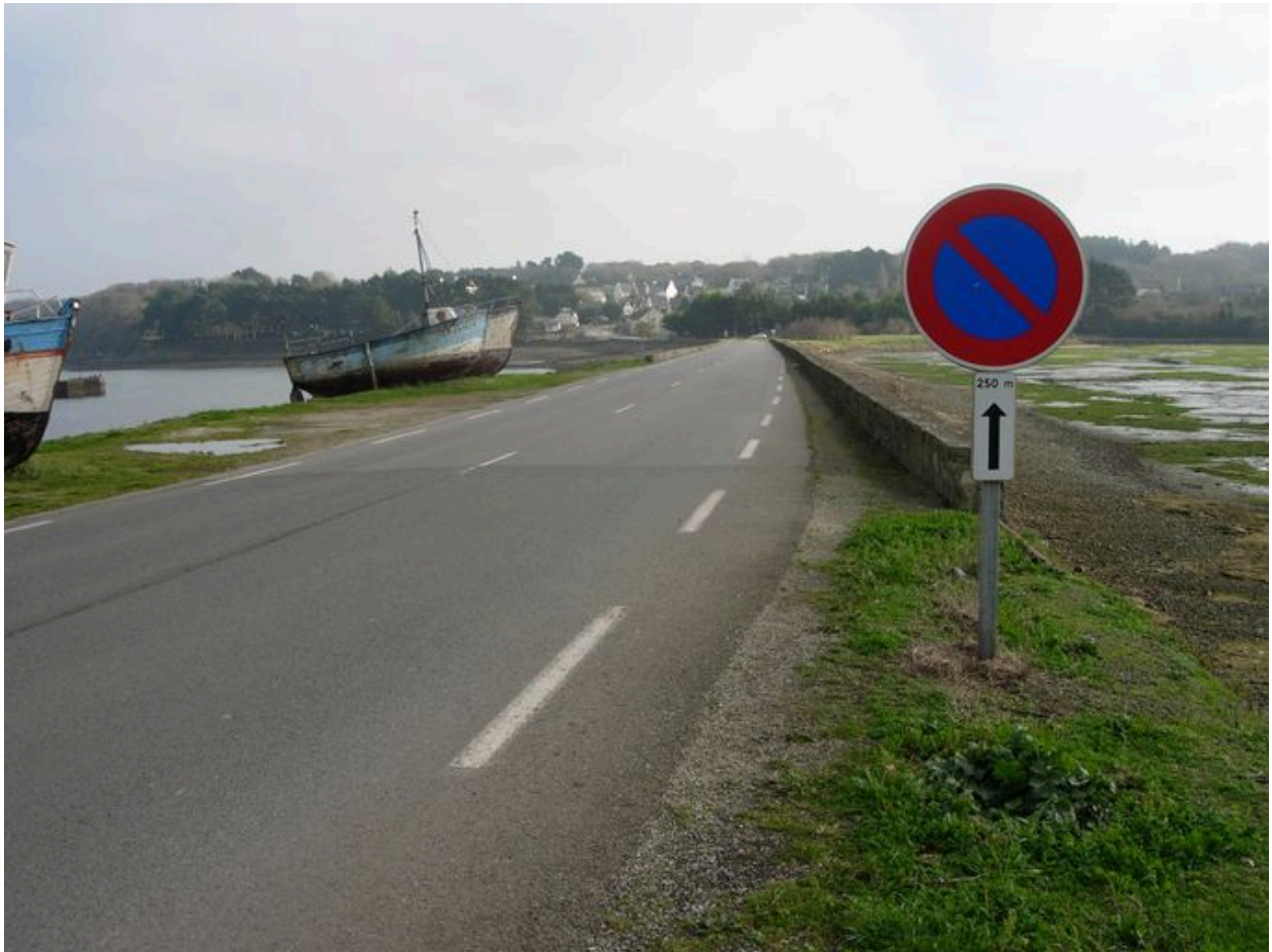
Vue générale de la digue-route du Sillon
