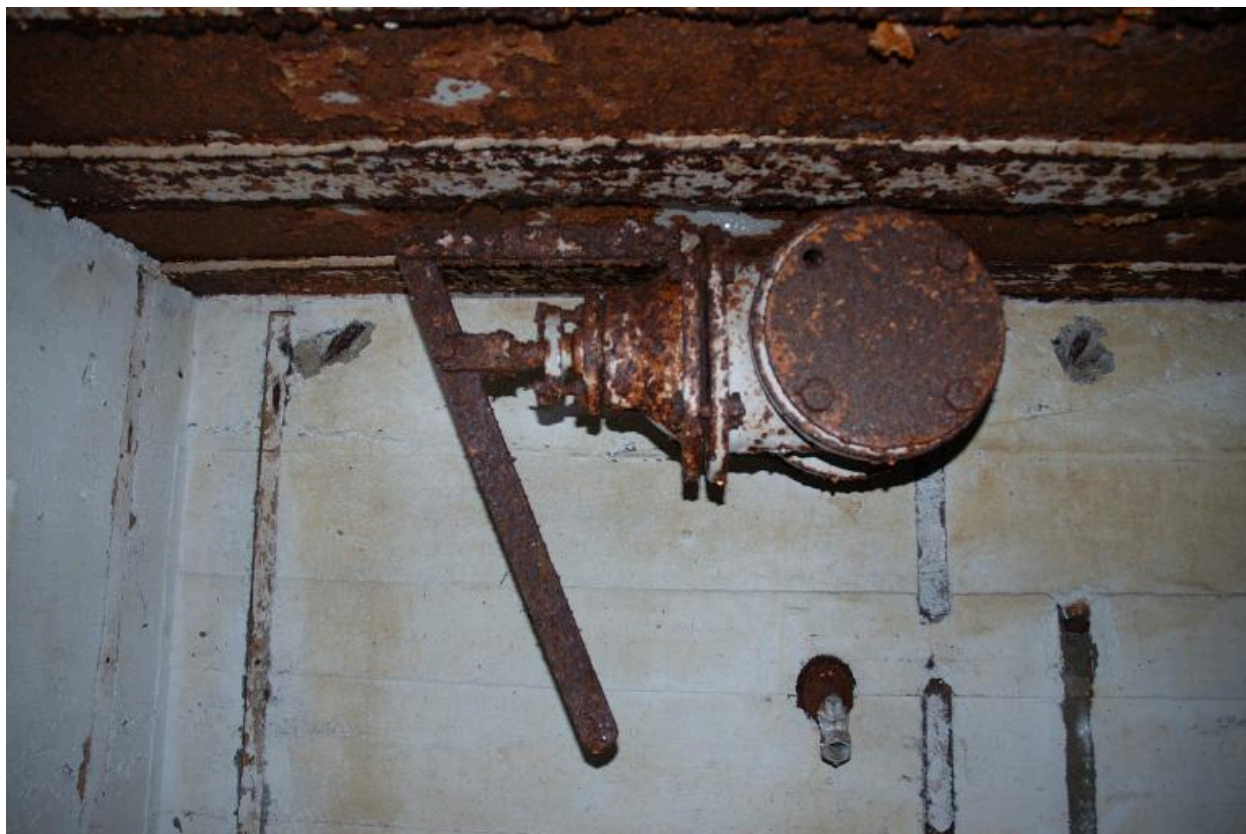
Vue de la chambre de troupe de gauche : vanne (état en 2005)
