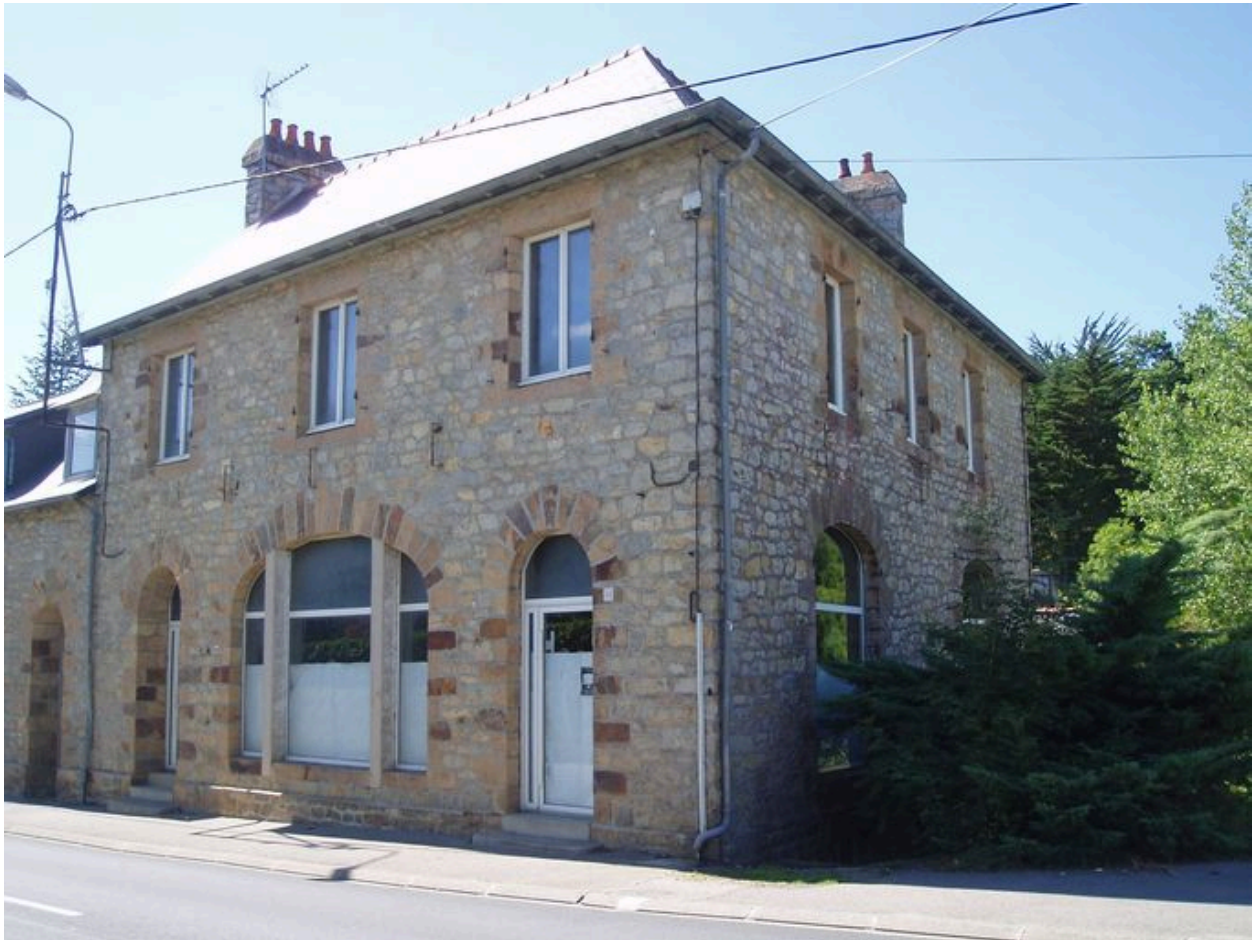
Partie gauche de la maison accolée à l'ancienne épicerie Félix Potin
