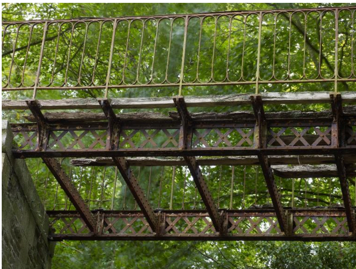
Passerelle métallique. Tablier vu du dessous : poutrelles rivetées fixées sur les poutres en treillis
