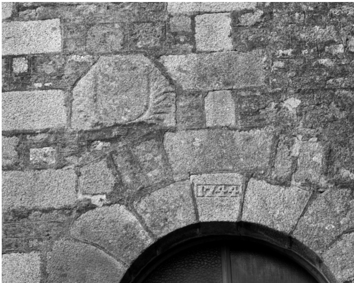
Elévation Sud, porte datée : détail de l'inscription
