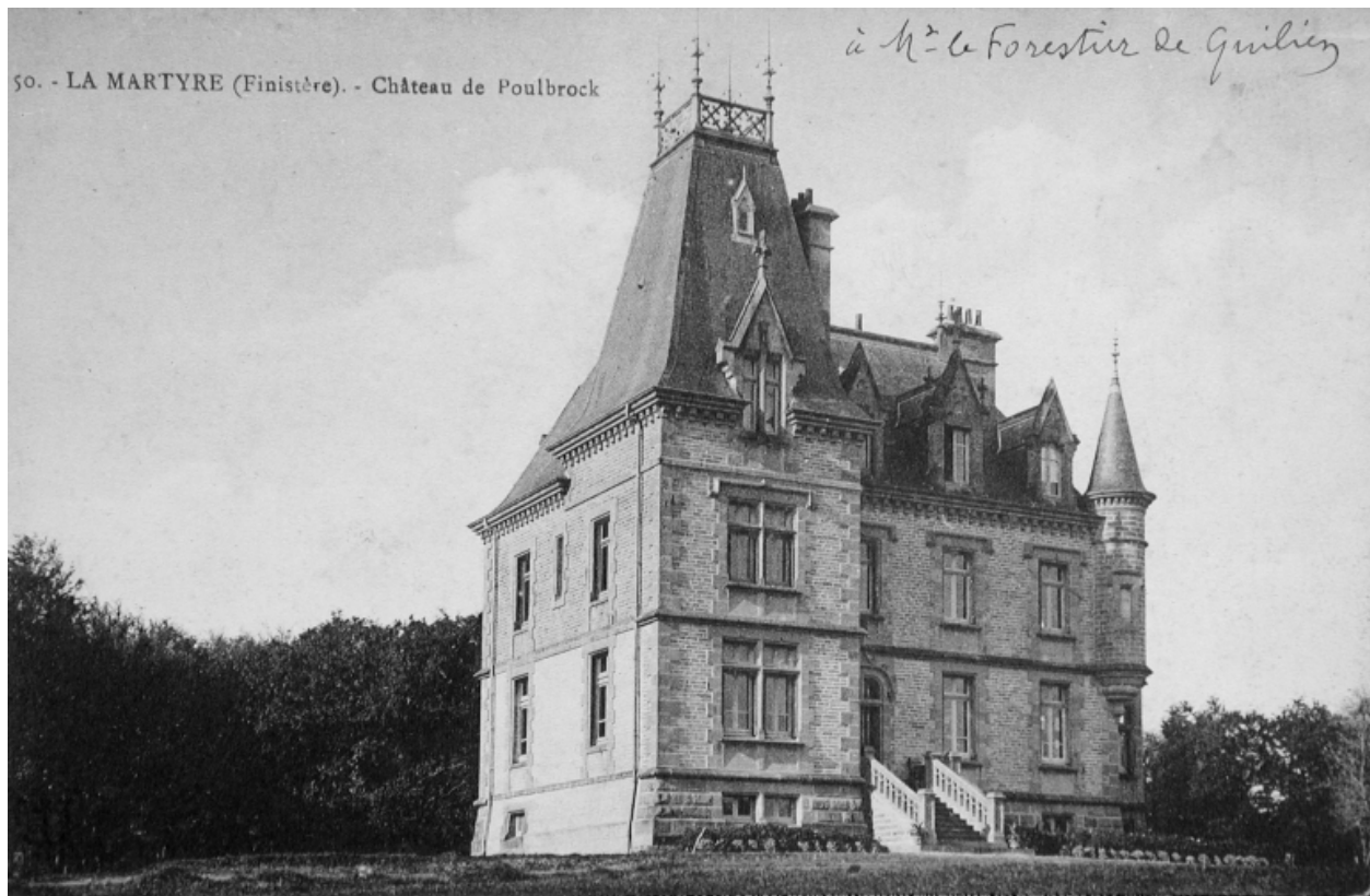
Vue de la façade postérieure
