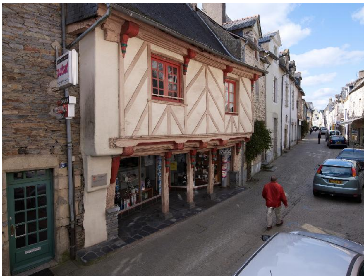
Maison : élévation principale vue de l'est (état en 2012)
