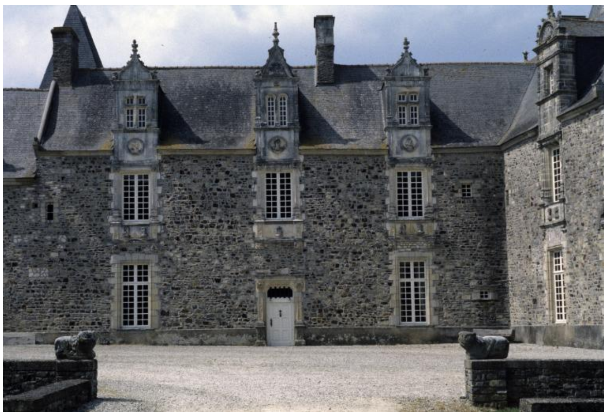
Vue rapprochée du logis.
