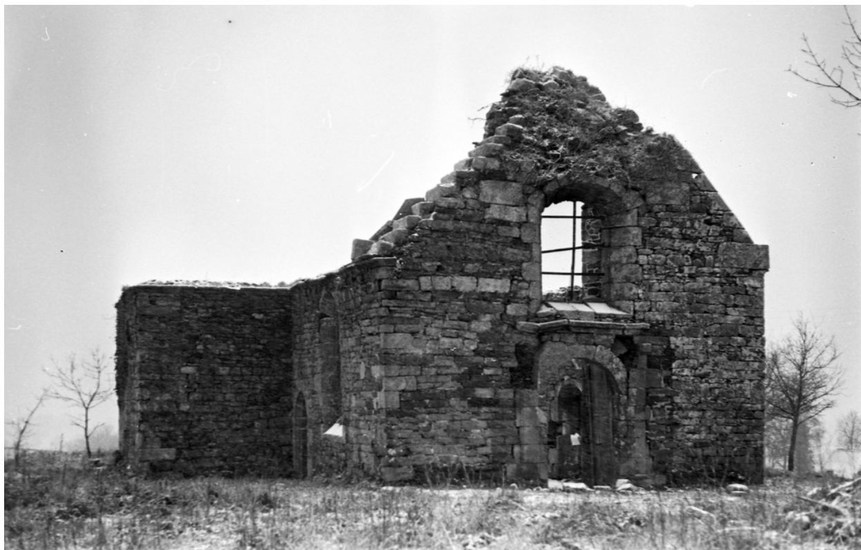
Vue générale ouest
