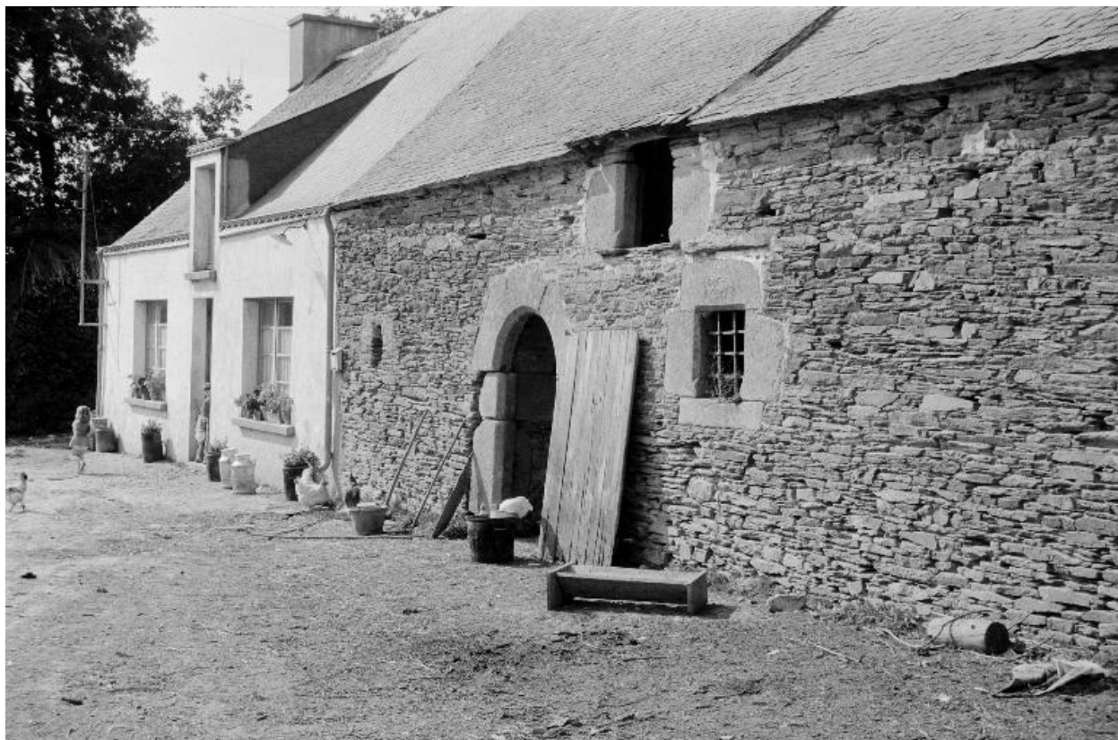
La Rue des Bois : ferme datée 1666 sur le linteau de la fenêtre (état en 1969)
