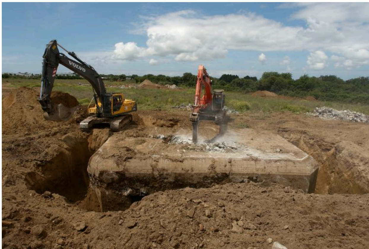
Déconstruction d'un bunker de type 502
