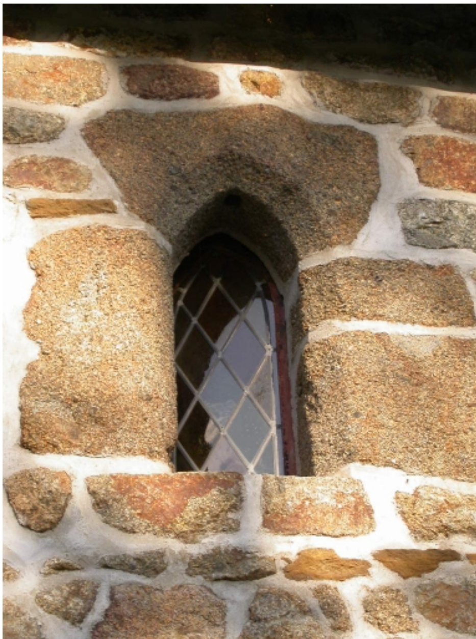
Baie située en façade postérieure du logis
