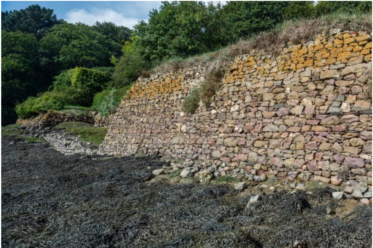
Cale en pierre sèche du four à chaux de Plouguiel
