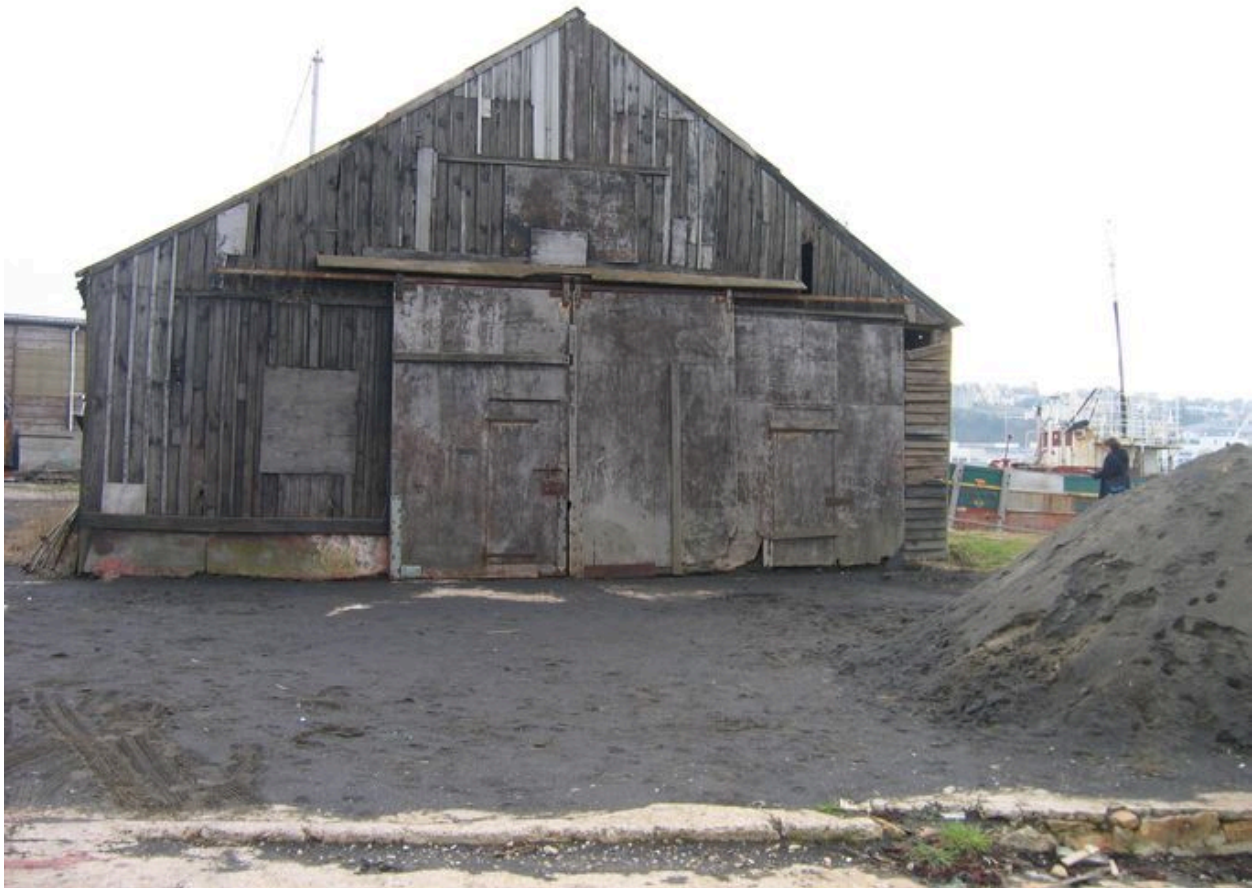
Vue latérale de la cabane de sablage
