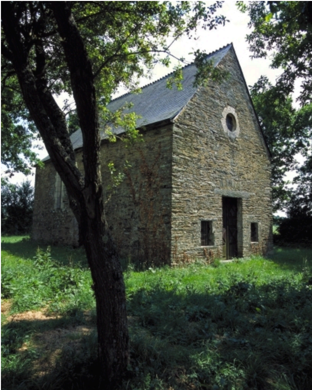
Elévation nord-est : vue générale
