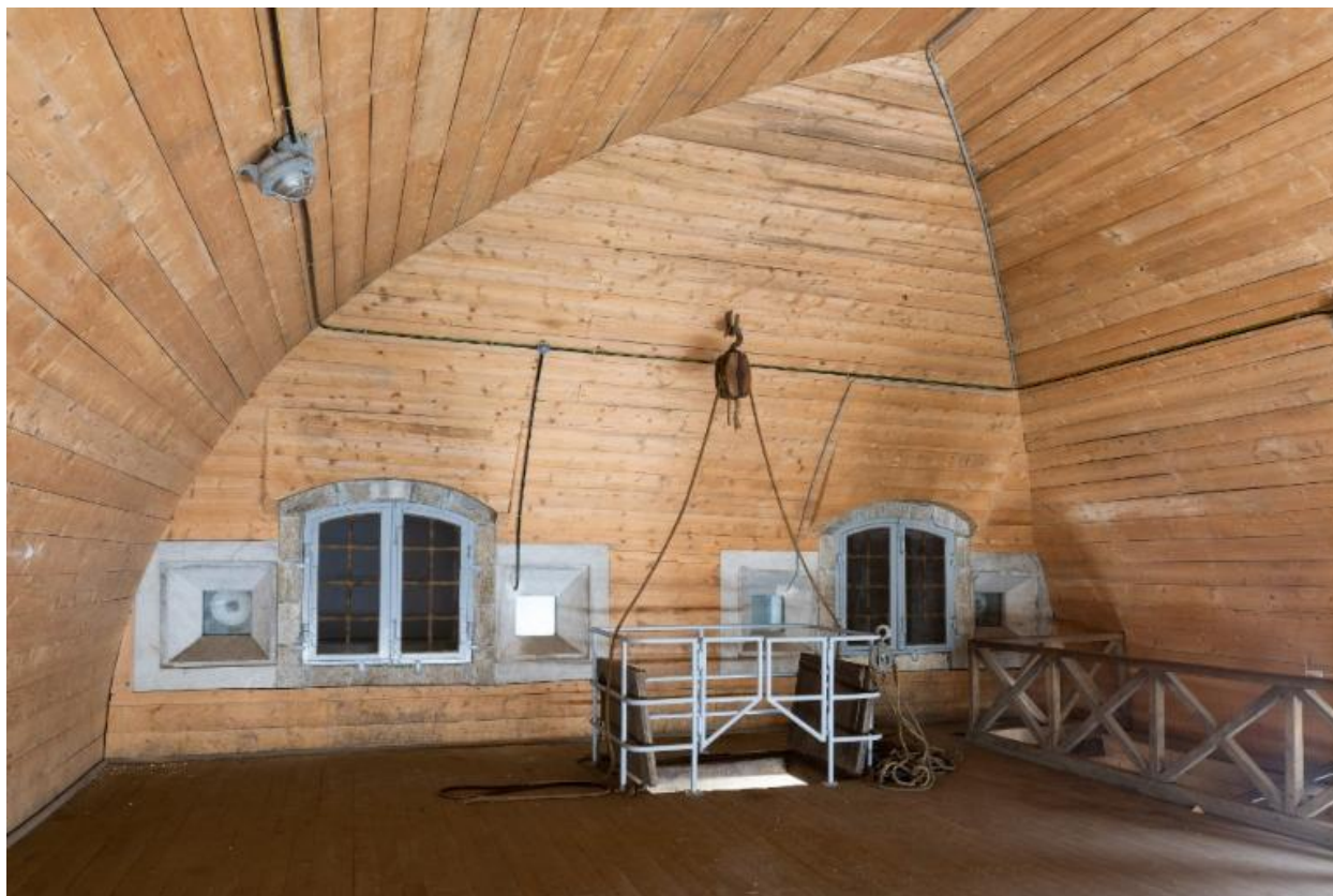
Vue intérieure de la poudrière n° 3 (P3) de la vallée de Kerhuon : premier étage, extrémité sud, palan permettant les manutentions par une trappe aménagée dans le plancher (état en 2025). En arrière-plan : fenêtres et créneaux à lampe ; à droite, escalier
