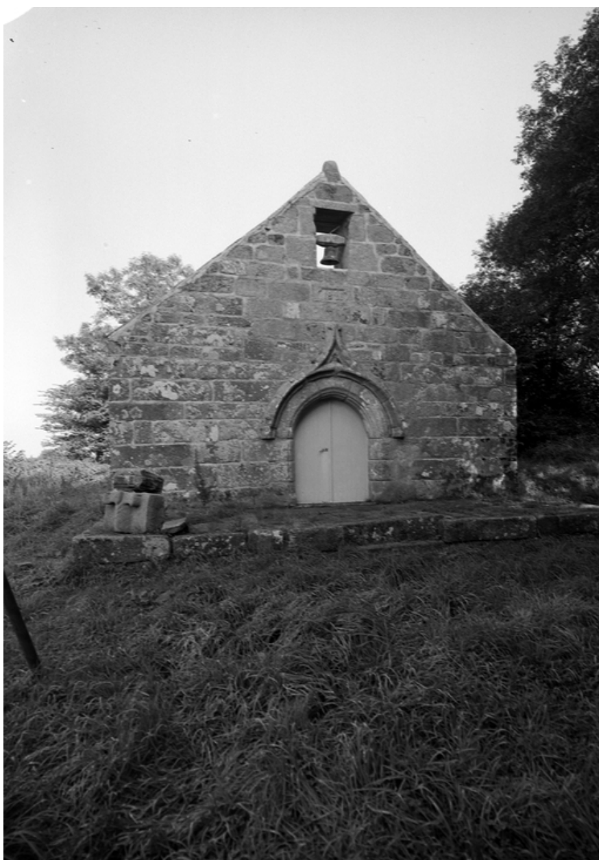
Face ouest : vue générale
