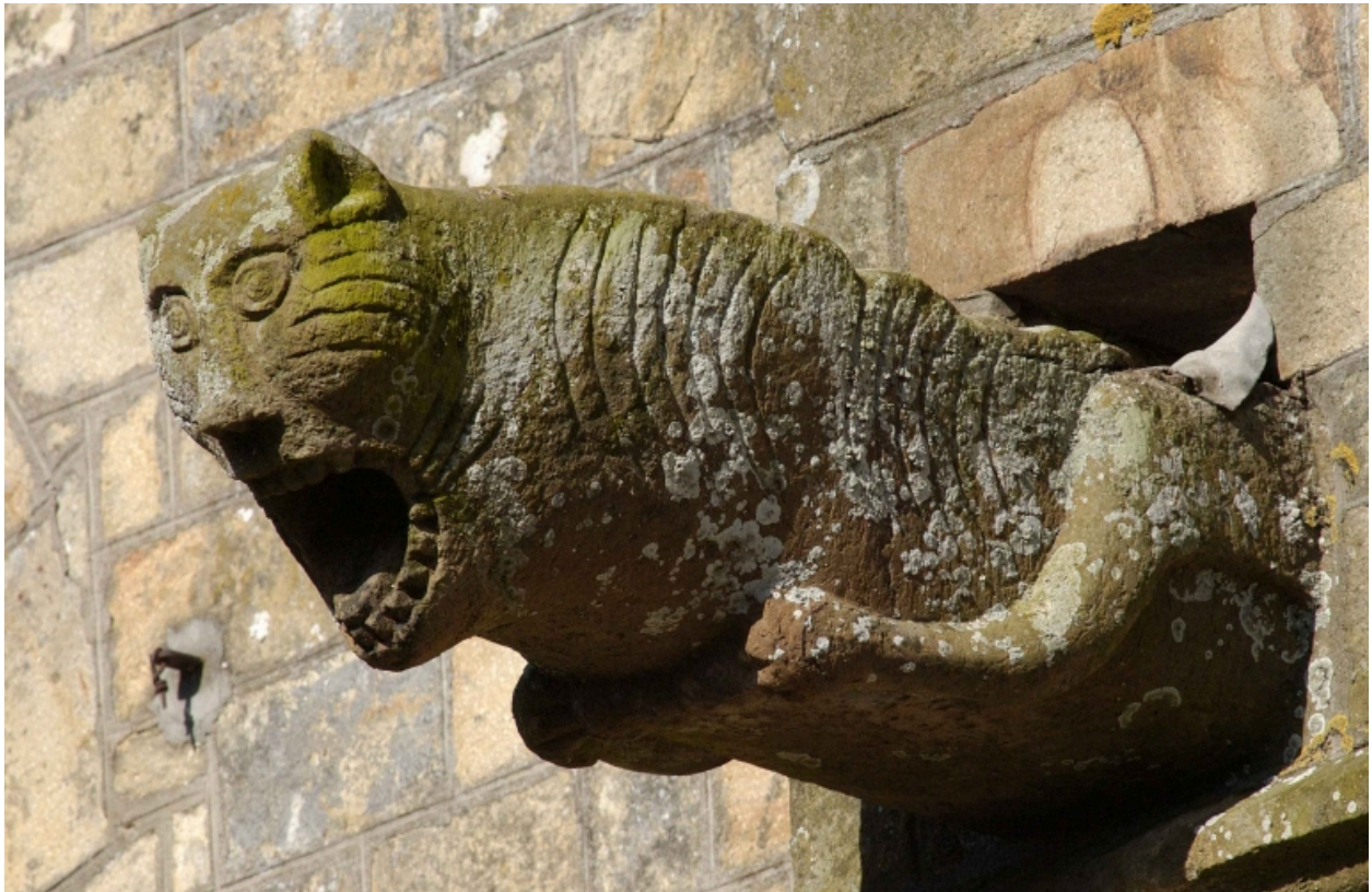
Façade sud, détail, gargouille d'un contrefort
