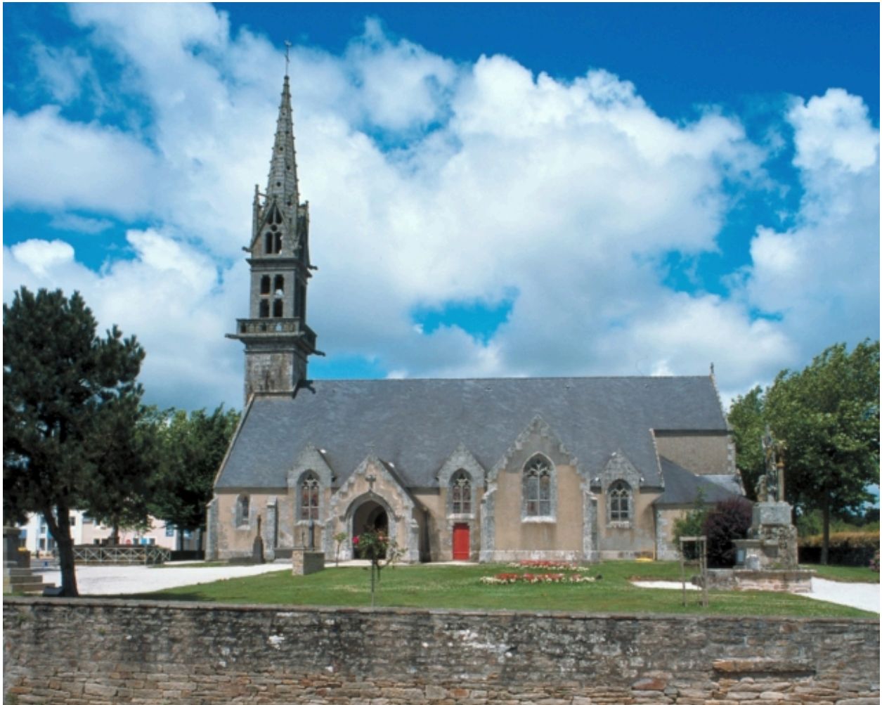
Mellac, église paroissiale Saint-Pierre-aux-Liens : élévation sud, vue générale, état en 2000
