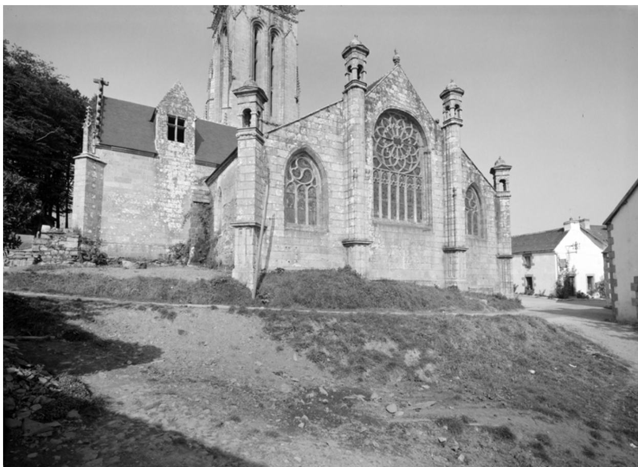
Vue générale du chevet
