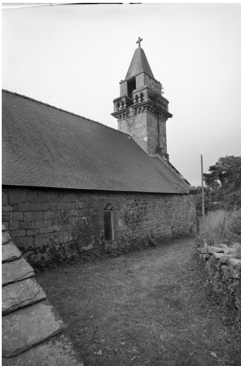
Elévation nord : vue prise du nord est
