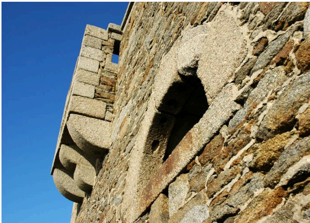
Elévation Ouest : détail de la bretèche Nord
