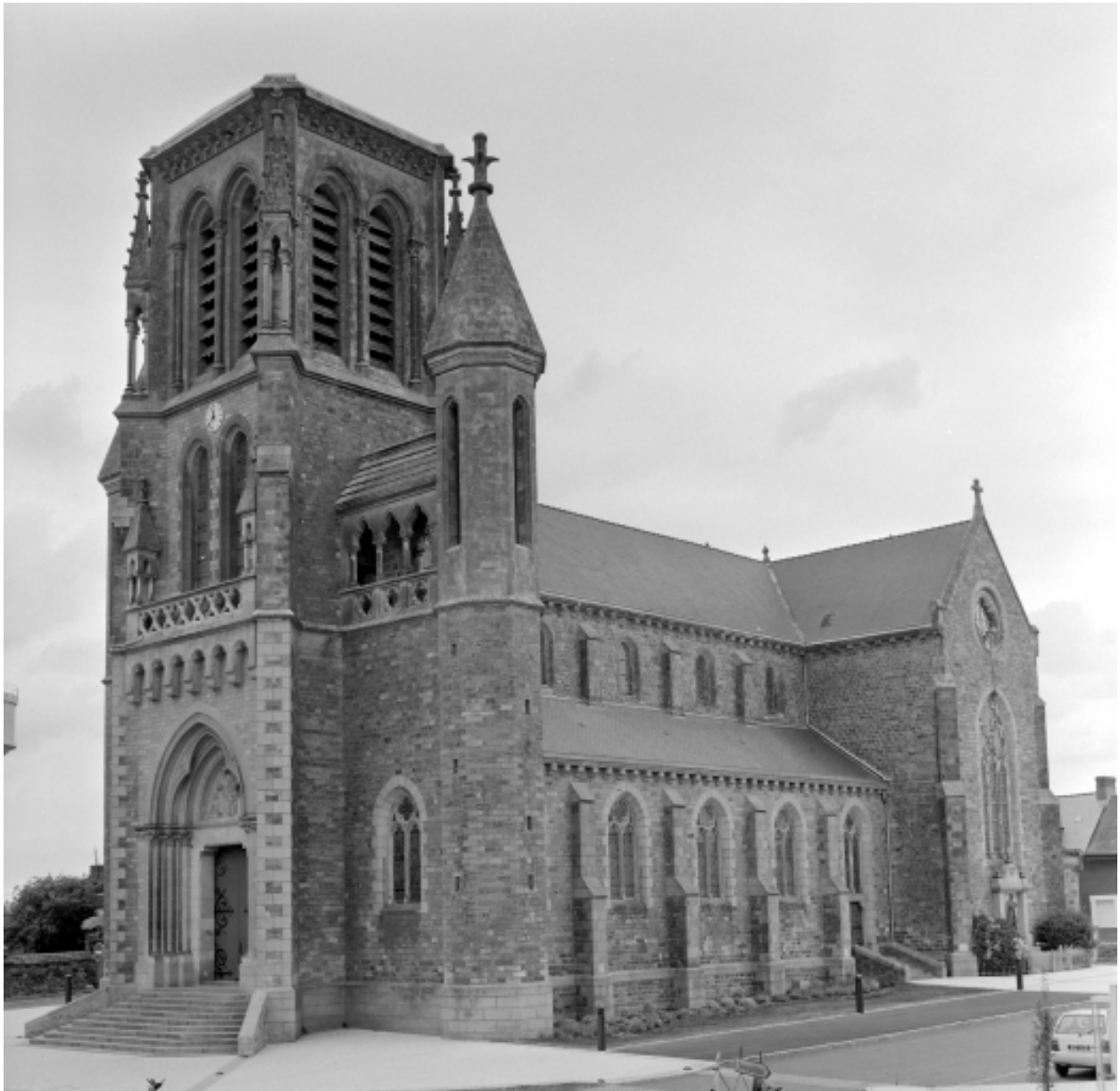
Elévation Sud-Ouest : vue générale
