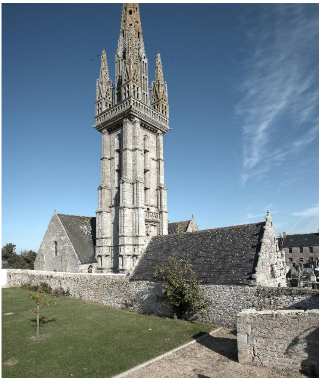
Vue sud-ouest de l'église
