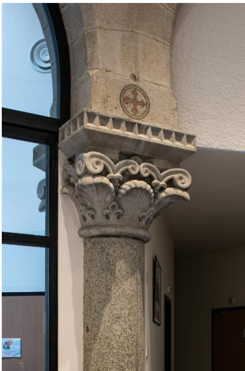
Chapelle : détail sur le chapiteau d'une colonne enchâssée.
