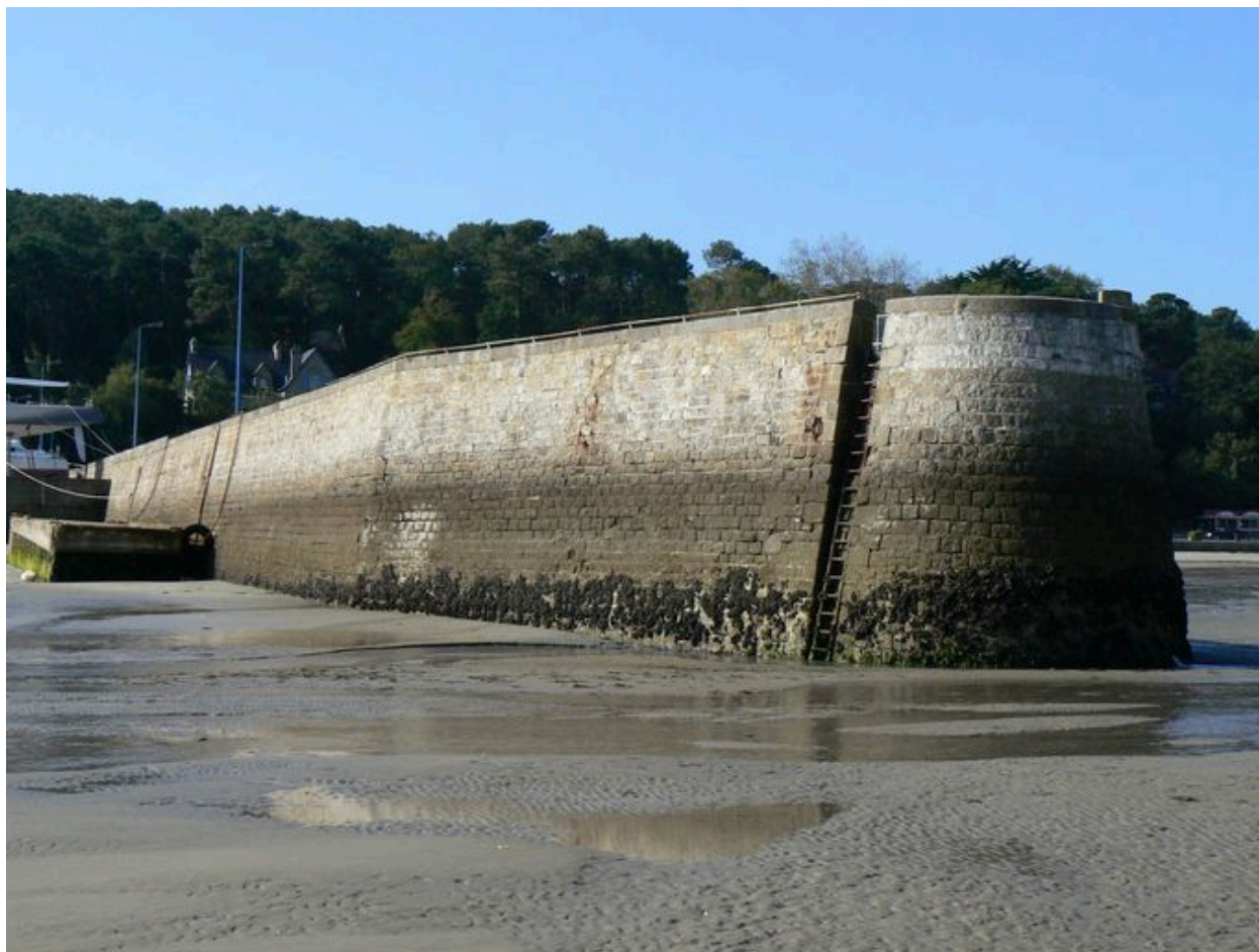
Transit terre/mer : môle portuaire du Kador à Morgat (Crozon)
