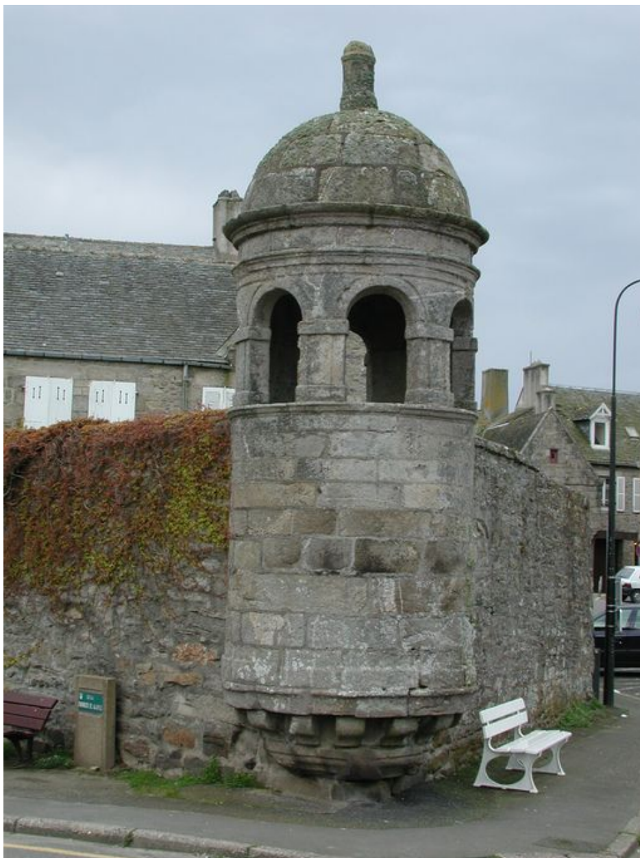
Vue du mur de clôture du jardin et de l'échauguette/guérite (dominant à l'origine la mer)
