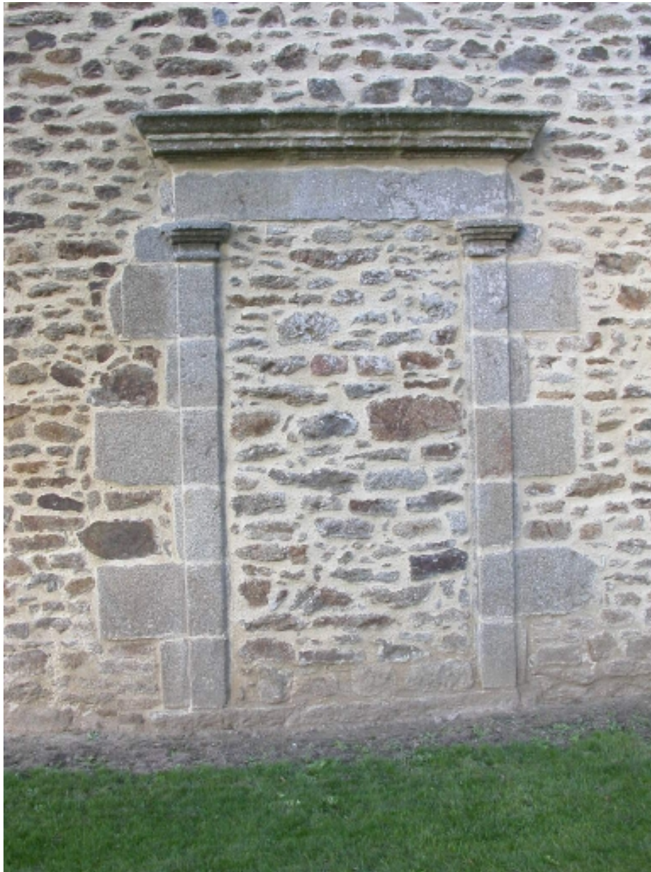
Baie murée, mur sud
