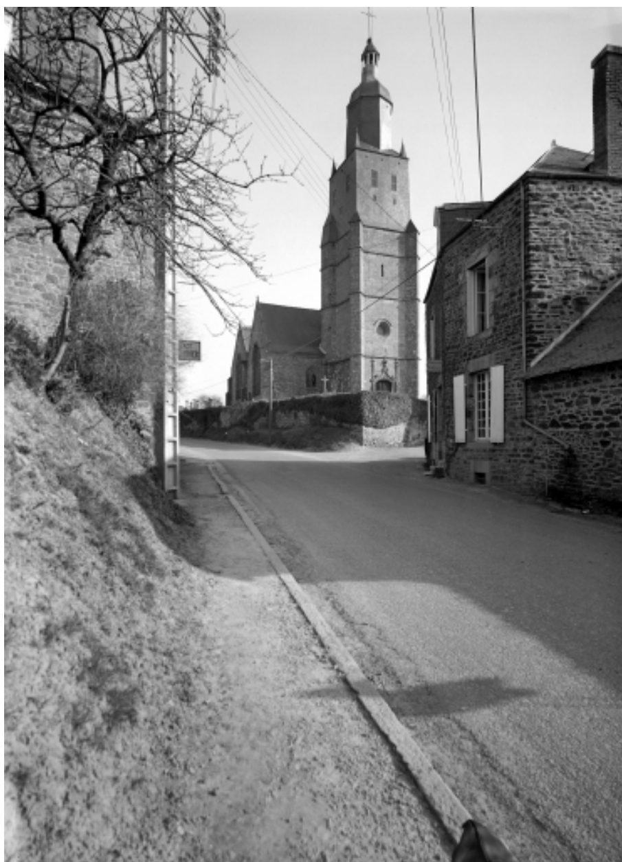
Elévation Nord-Ouest : vue générale
