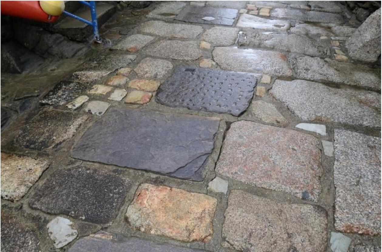
Pavage de la cale : moellons de taille différentes et origine géologique diverse
