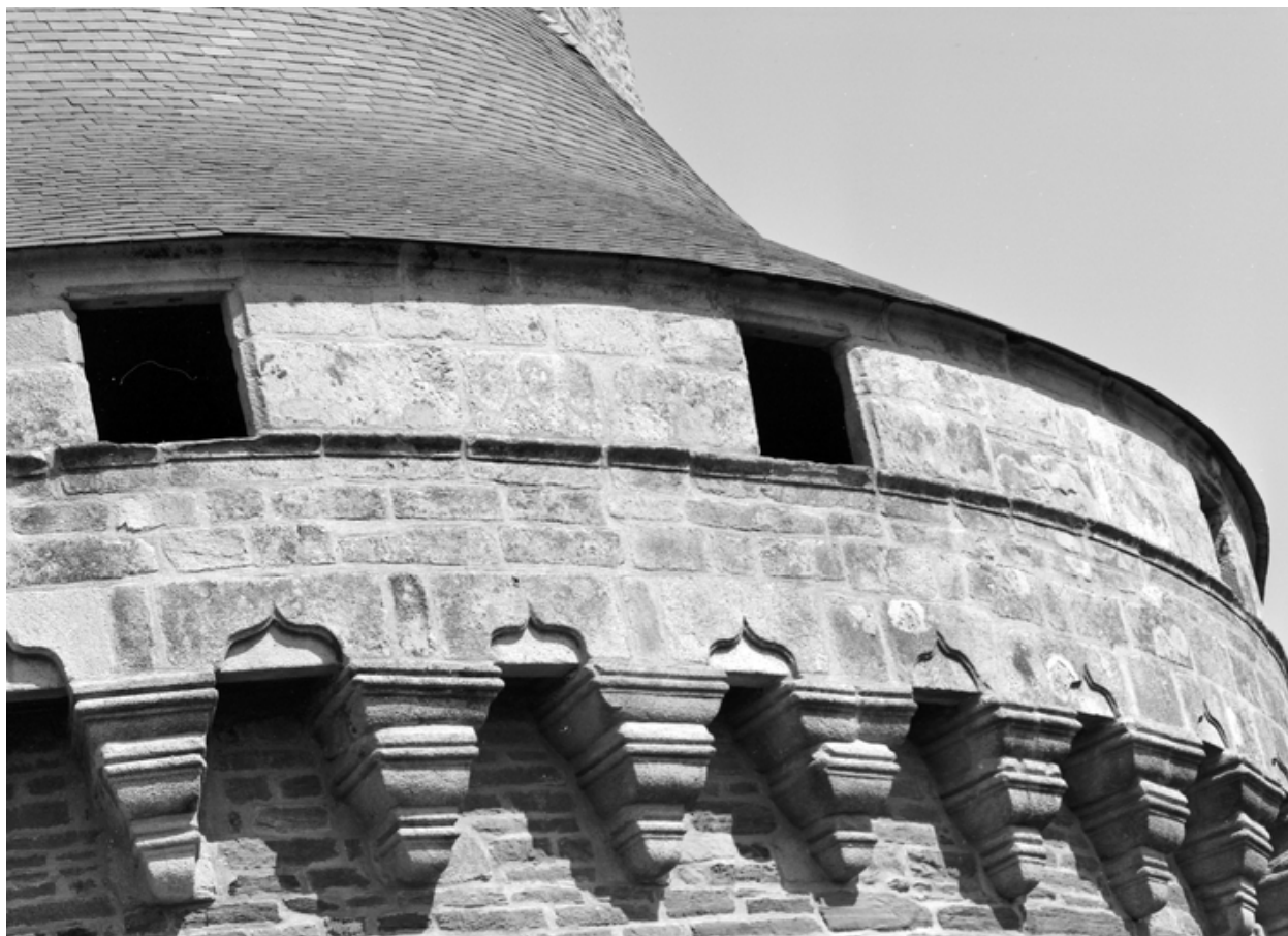
Tour sud-ouest, détail des mâchicoulis.
